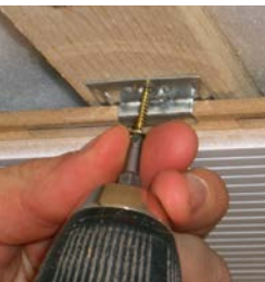
Befestigung mit Montagekrallen
